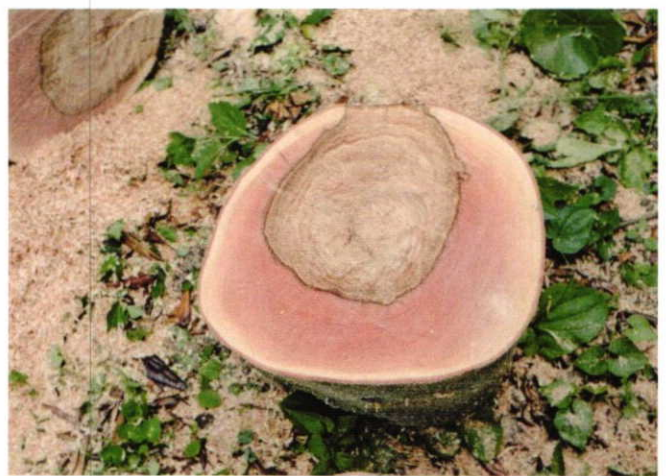
高さ60cm－断面の約50%腐朽
