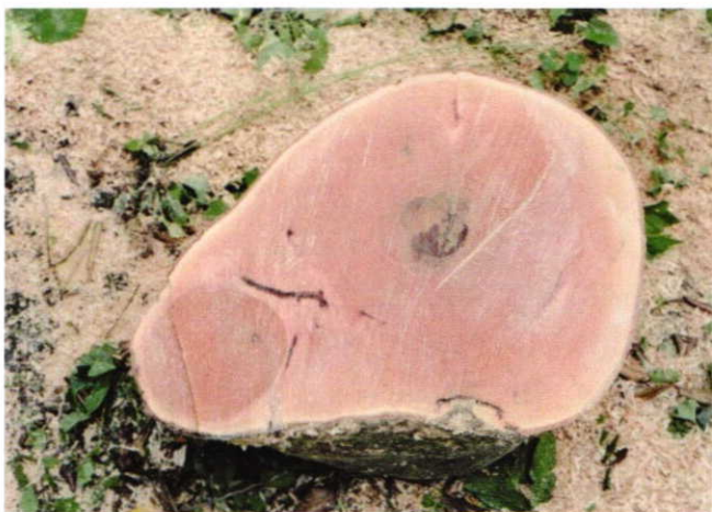
高さ100cm－断面の約20%腐朽
