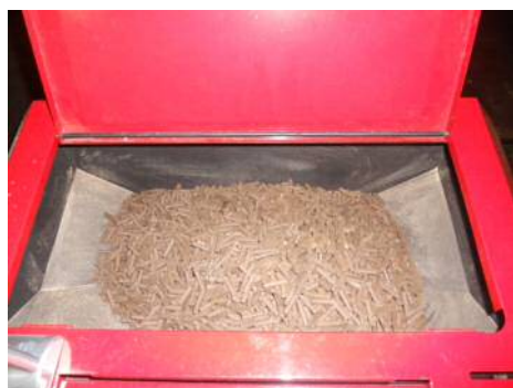
3. ペレットタンク内の様子
