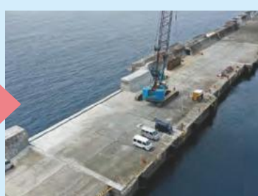
施工状況 (令和元年7月18日)
