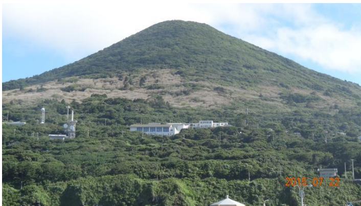
写真3 利島村被害地遠景 (平成 27 年 7 月 22 日)
